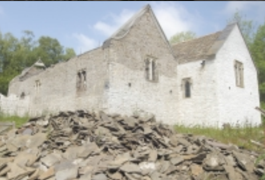
Leah Jones yn ysbrydoli ymwelwyr i edrych y tu hwnt i'r rwbwl wrth i'r gwaith o ailadeiladu Eglwys Sant Teilo fynd yn ei flaen Leah Jones inspires visitors to see beyond the rubble as St Teilo's Church is rebuilt
